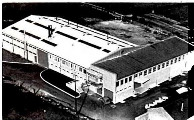
Vue d'avion l'usine des boules OBUT est imposante. Pourtant elle se révèle déjà trop petite pour pouvoir assurer la fabrication des boules en commandes si bien que déjà un plan d'agrandissement est à l'étude.
