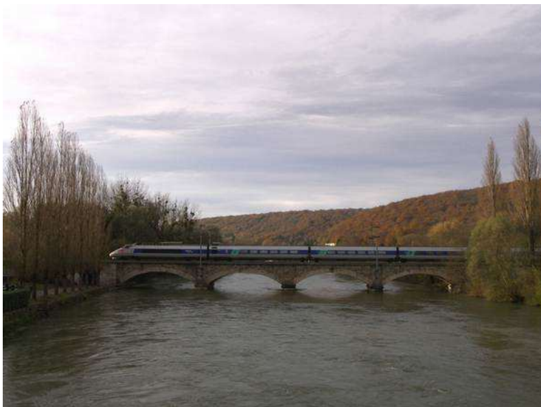
Le pont S-N-C-F de Voujeaucourt, qui permet aux TGV de traverser la rivière Doubs, pour relier Besançon à Belfort
