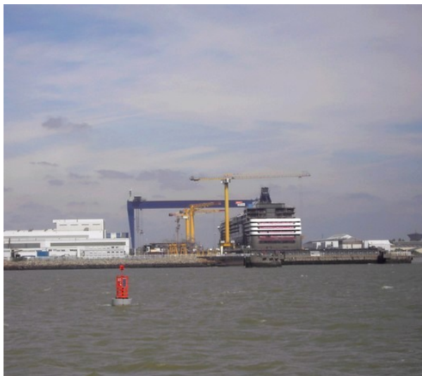
Les chantiers navals de l'Atlantique à Saint-Nazaire, implantés sur l'estuaire de la Loire
