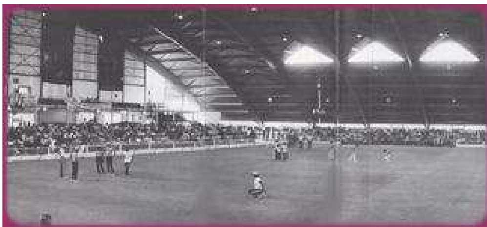
Une vue générale des phases finales dans le Hall des Foires de Tours
