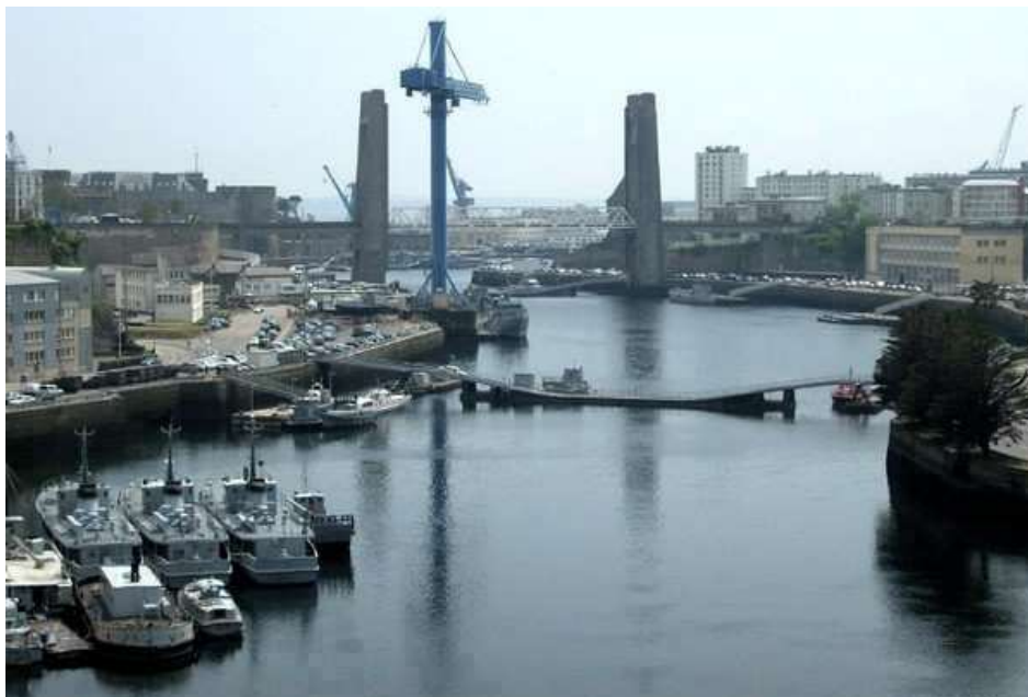
Le pont-levant de la Recouvrance, sur le fleuve côtier Penfeld, qui débouche vers la Base Navale de Brest
